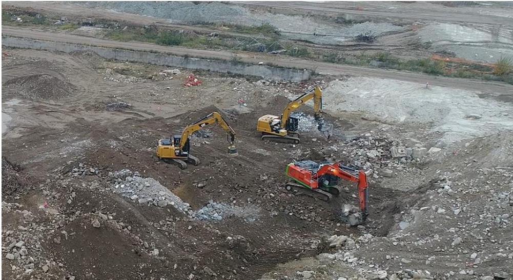
Figure 5 : Atelier de préparation (pince à béton, pelle à godet, pelle à aimant)
